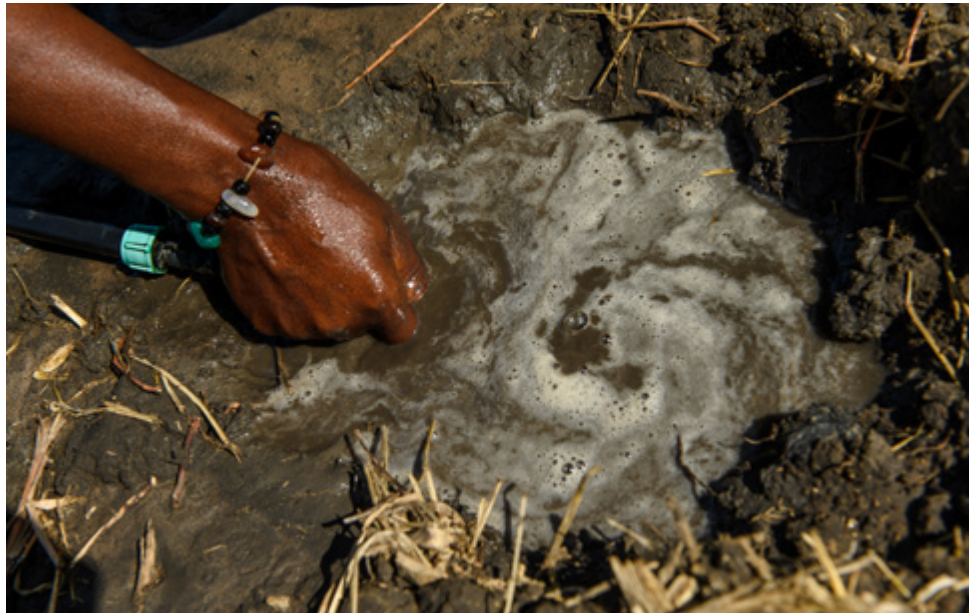
Ami répare un tuyau qui fuit.
